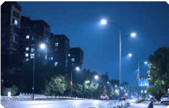
▶ 杭州城市道路照明工程
