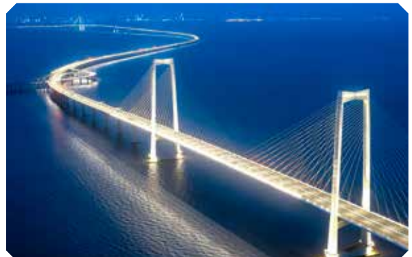
▶ 深中通道照明工程
