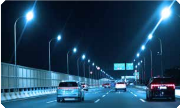
▶ 上海城市道路照明工程
