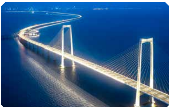
▶ 深中通道照明工程
